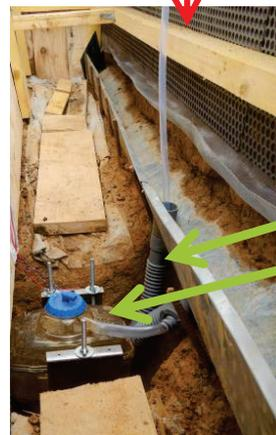
Face amont : tôle percée et grillage fin
